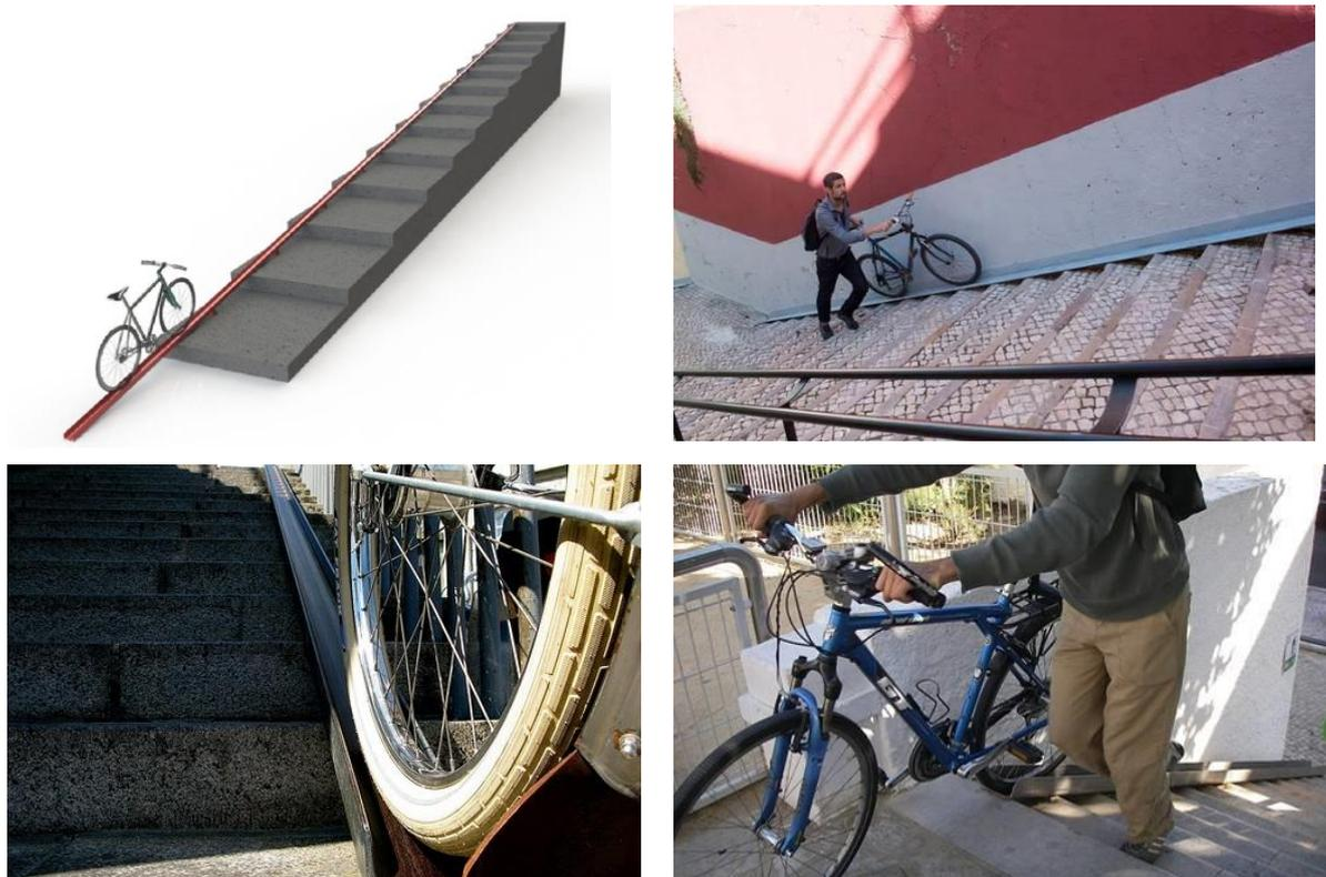
Figura 59. Exemplos de utilização da calha metálica em escadarias, Lisboa
