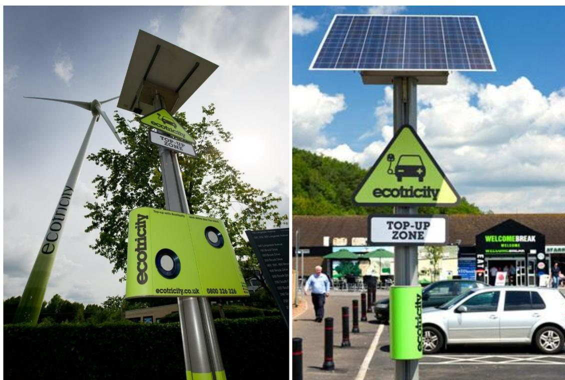
Figura 96. Postos de carregamento elétrico proveniente de energias renováveis – Reino Unido
