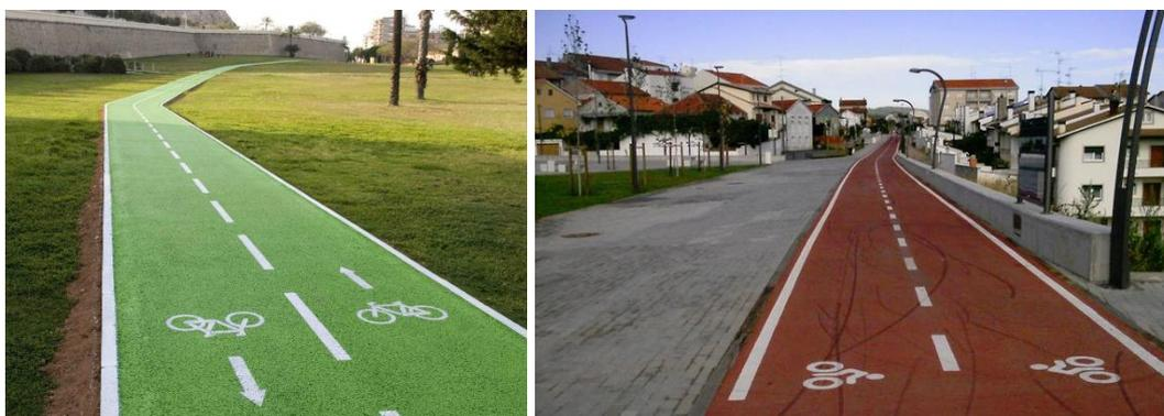
Figura 48. Imagens de referência da aplicação do pavimento em betuminoso colorido
