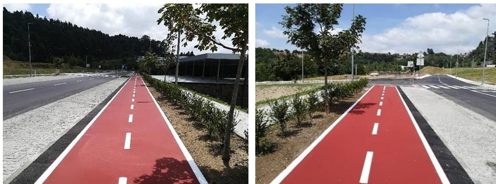
Figura 54. Imagem de referência da aplicação do pavimento betuminoso com revestimento slurry
