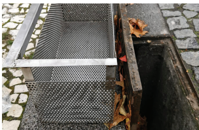
Filtros de retenção em sumidouros (7)
