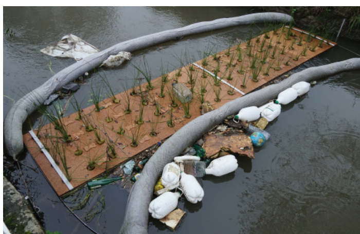
Protótipo da "EcoBarreira" no rio Selho (6)
